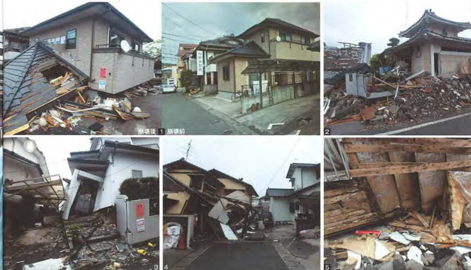
1 築年数が浅いにも関わらず倒壊した住宅。被災直後の人命救助のため、屋根を切断した痕跡がある。この住宅はGoogleストリートビューにより倒壊前の状況が確認できた 2 本堂が倒壊し、納骨堂だけが残ろうじて残った寺院 3 倒壊した建物に加え、宅地自体も「危険」と判定された家屋 4 隣り合う2棟のうち向かって左の1棟が崩壊した。左の建物は敷地が2方向にわたって水路に面していた 5 外壁が剥落した倒壊家屋をよく見ると、木ずりが失われるほどの蟻害を受けていた。
