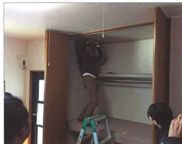
クローゼットの点検口から小屋裏を調査中の山本尚志氏
