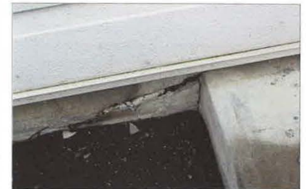
基礎部分に生じたひび割れ
