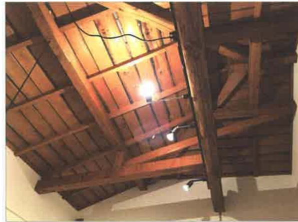
改修後の2階小屋裏、構造を見せた仕上げに
