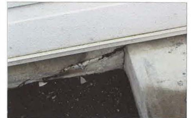
基礎部分に生じたひび割れ
