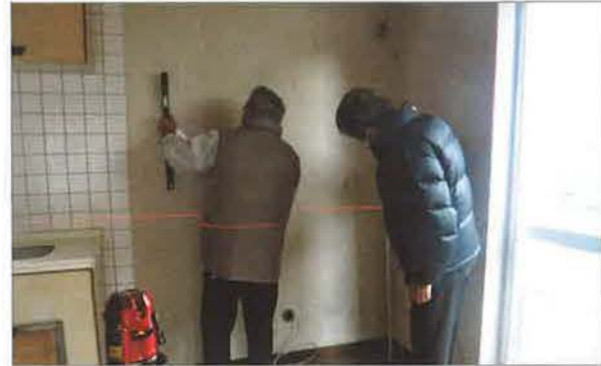
水平器で壁を計測中
