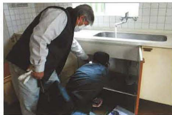
キッチン水栓を開いて排水をチェック中の菅雄治氏ら
