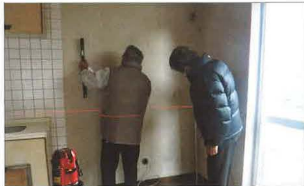
水平器で壁を計測中
