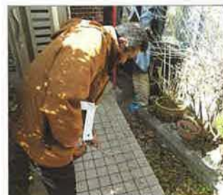
玄関前スロープの状態を打診棒を使って確認する参加者
