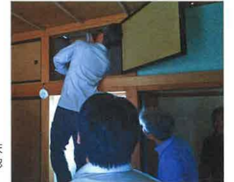
天井点検口から天井裏の状態を確認している様子
