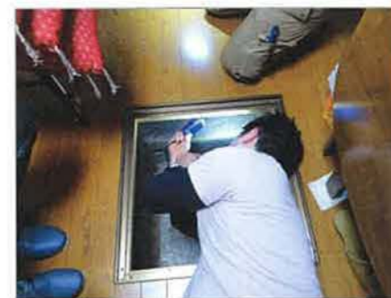
点検口から上半身を入れて床下の状態を撮影する
