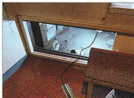
床下に潜らずに見学できるように電灯を入れて内部を照らす
