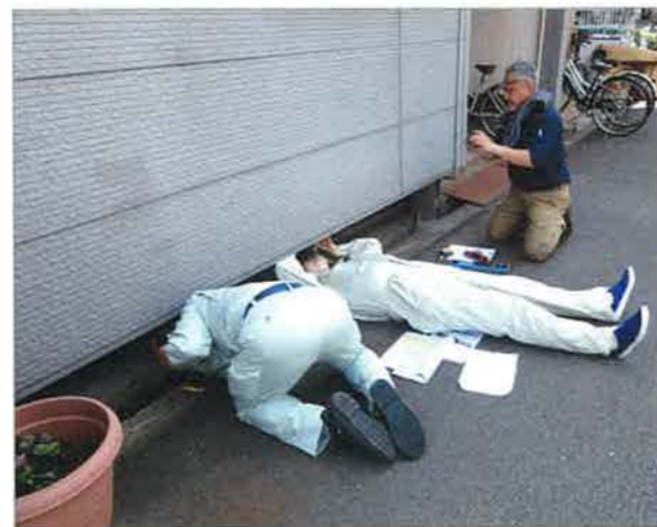
持ち出し外壁の内側と基礎の状態を確認中
