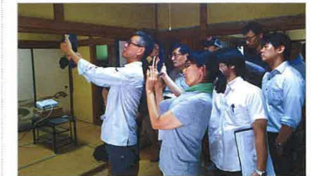
赤外線サーモグラフィカメラの表示画面を皆で確認
