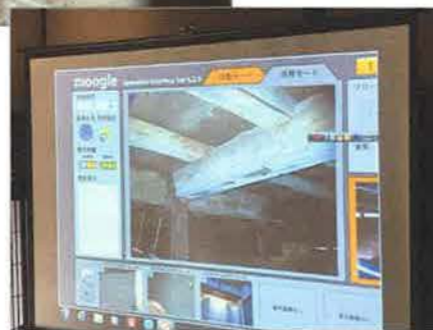
「moogle」が届ける映像。かなりはっきりと床下の状況が確認できました
