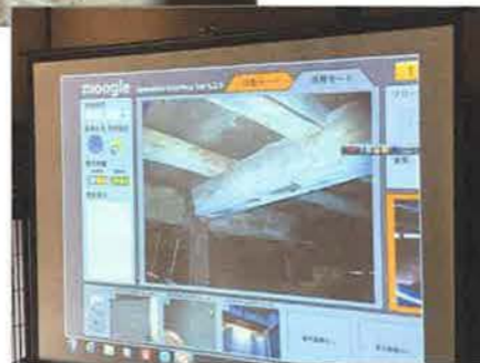
「moogle」が届ける映像。かなりはっきりと床下の状況が確認できました
