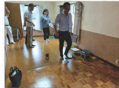
松田貞次エリア部会長が、床の状態を歩いて確認する診断方法を解説
