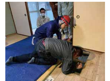
▲26日 床下侵入調査
