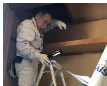
▲天井裏をインスペクションする場面
