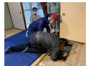
▲26日 床下侵入調査
