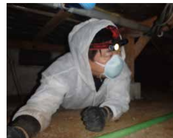
▲床下進入の様子
