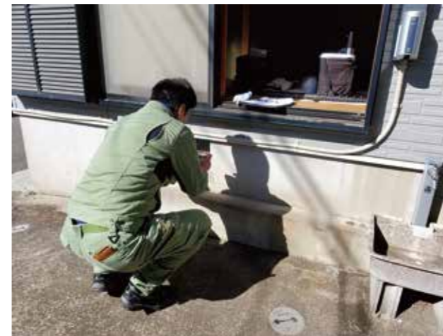
▲ ひび割れなどの事象をデジカメで撮影
