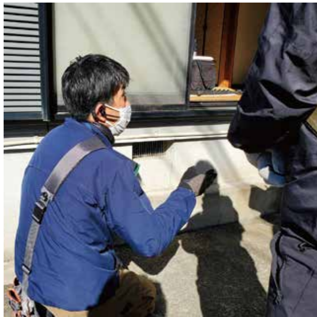
▲ 基礎のひび割れについて調査方法などを説明する
