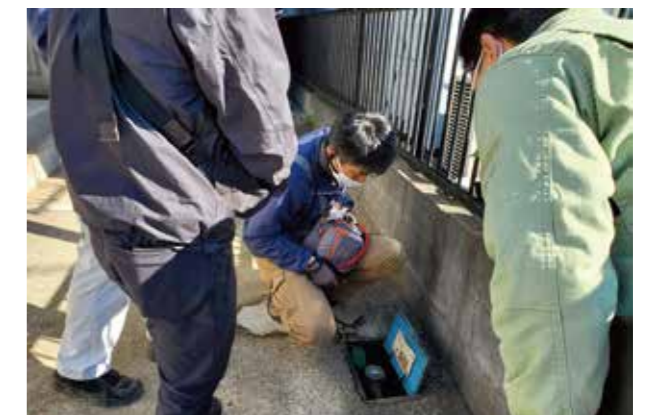
▲ 水道の開栓状態を確認する
